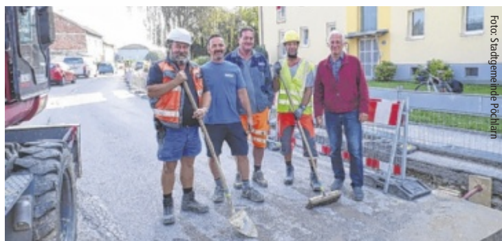
In Pöchlarn beginnen die ersten Arbeiten zur Sanierung der Wasserleitung.
